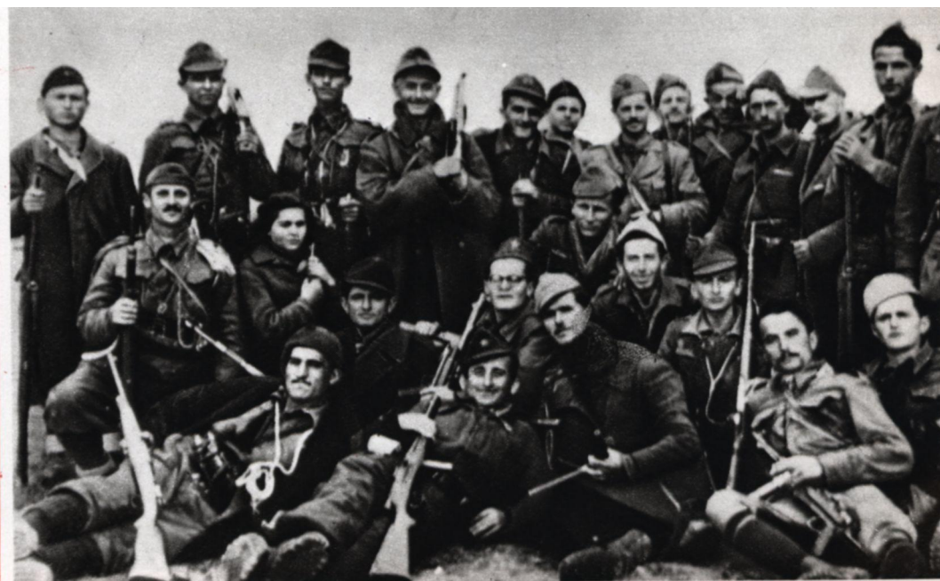
Luftëtarë dhe kuadro të Brigadës V S.
